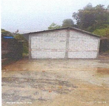
Foto 3: Módulo parte de atrás
